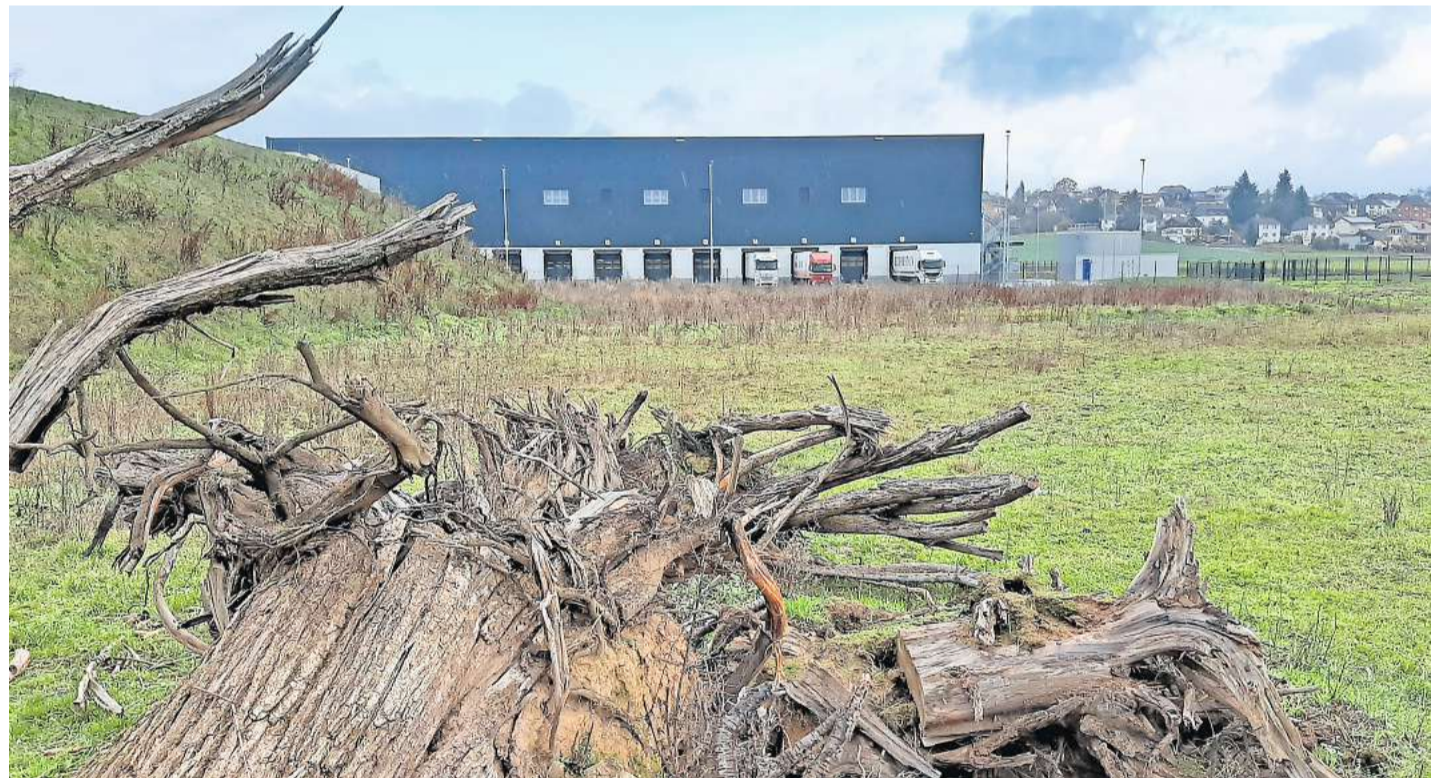
Die Logistikhalle der Firma Depro & Kautetzky vom Bahnhofsweg aus gesehen.
